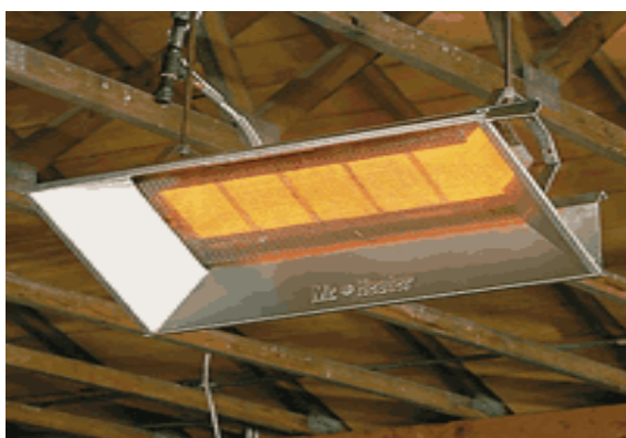
Εικόνα 2-d: Υπέρυθρα συστήματα τύπου Blackheats (πάνελ και διπλού σωληνωτού)
