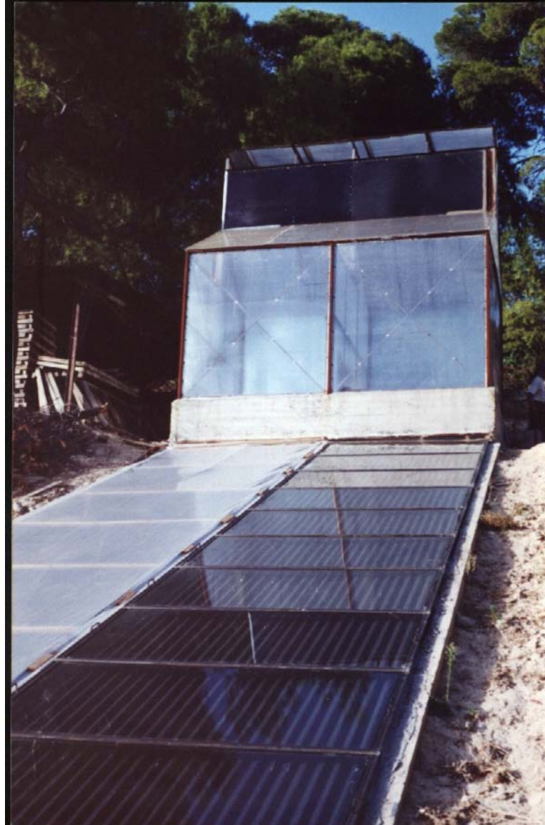
Φ.3.7. Διάταξη χωρίς ανεμιστήρα, αλλά με ηλιακή καμινάδα.
