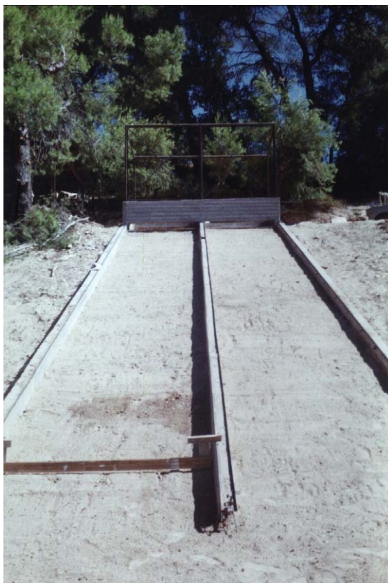
Φ.3.3. Η συνολική εγκατάσταση σε αρχικό στάδιο της κατασκευής.
